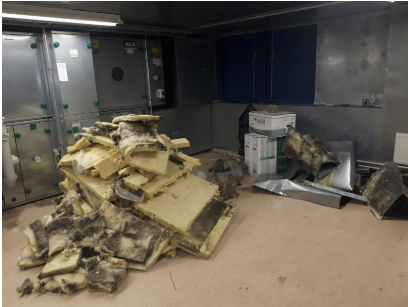
Kuvassa yhden IV-koneen tulo- ja poistokammioista poistetut kuitulähteet. Koneessa kiekko LTO.
