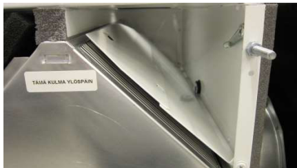
Lto-kenno kesä asennossa, pelti käännetty siirtimen eteen, ulkoilma ohittaa kennon takaa
