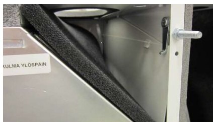
Lto-kenno talvi asennossa
