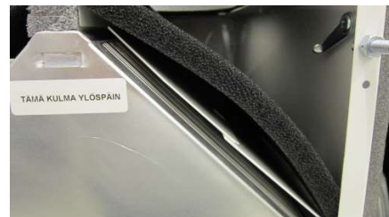
Lto-kenno kesä asennossa, pelti käännetty siirtimen eteen, ulkoilma ohittaa kennon takaa
