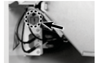
Jälkilämmitysvastuksen ylälämpösuojan palautuspainike (vain sähkömallit)
