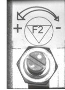
Poistoilmavirran potentiometri (sähköliitäntärasia)
