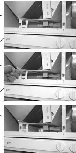
Vaihtopelti kesäasennossa. Vaihtopelti saadaan talviasentoon työntämällä pelti pidikkeen taakse.
