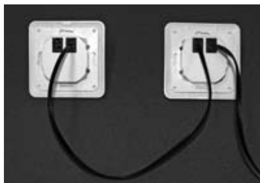
Sammankoppling av kontrollpaneler när två paneler används.
