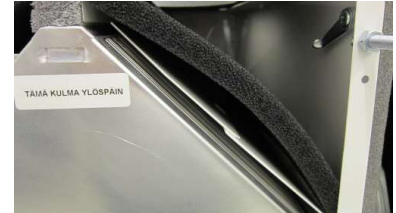
Lto-kenno kesäasennossa, pelti käännetty siirtimen eteen, ulkoilma ohittaa kennon takaa - aseta jälkilämmityksen termostaatti 0-asentoon
